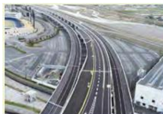
松山外環状道路空港線の側道部
