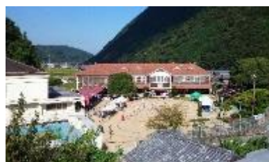
翠小学校の木造校舎
