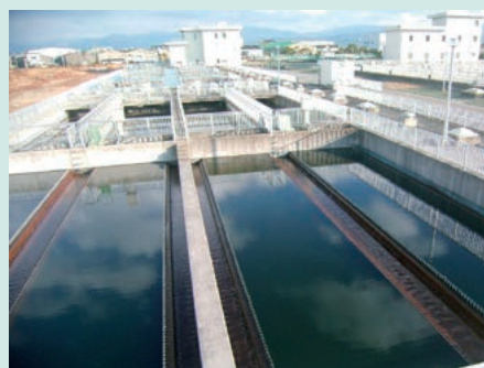
西部浄化センター 最終沈殿池(高度処理方式)
