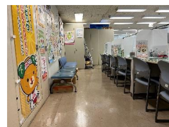
■別館：廊下幅の不足
