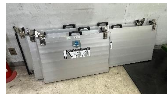
■機械室：止水板
