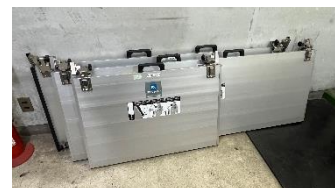
■機械室：止水板
