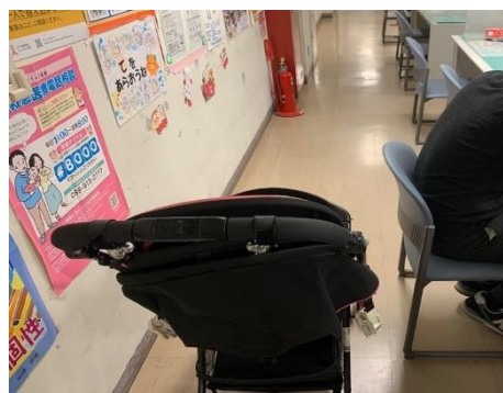
■別館：廊下幅の不足
