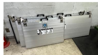
■機械室：止水板
