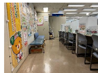
■別館：廊下幅の不足
