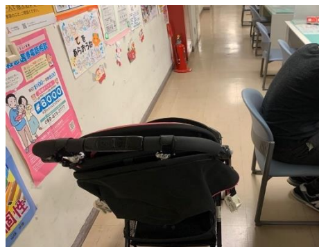
■別館：廊下幅の不足
