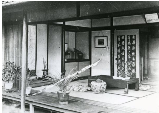
愚陀佛庵 1階室内(当時)
