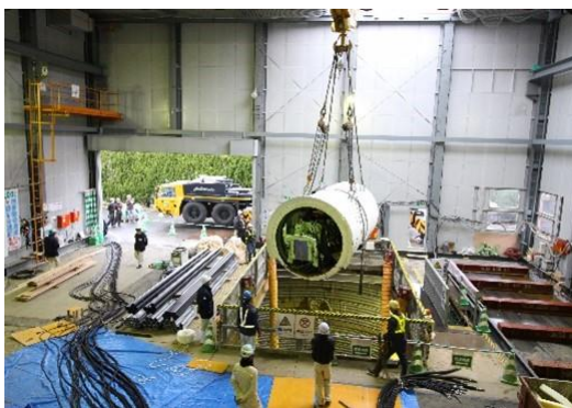
水道管の耐震化工事の様子
