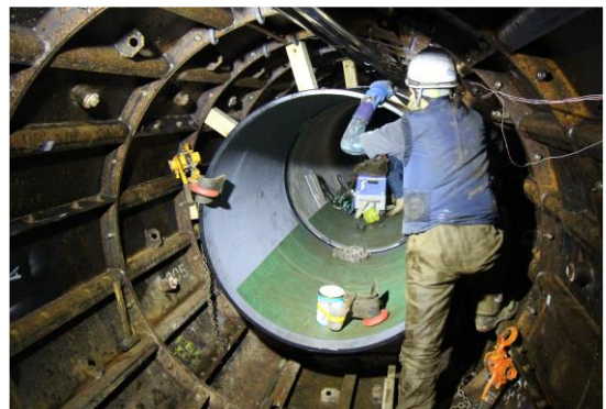
水道管の耐震化工事の様子
