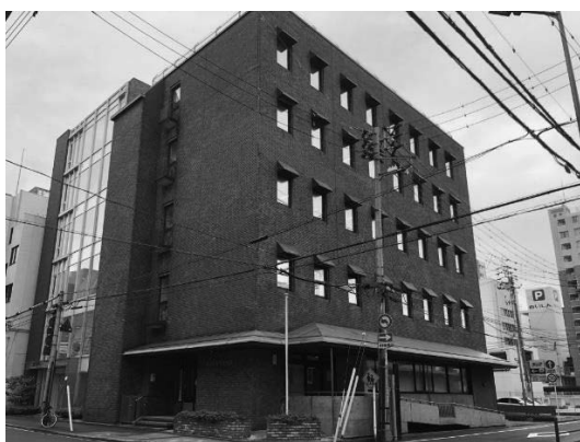
愛媛県松山市二番町／竣工 2004 年 3 月
