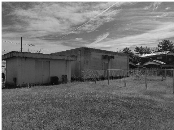
右建物 下流域の浄水場から上流域の浄水場に水を送るポンプ施設（井門町964番1） 左建物 地下から水を汲み上げ付近の浄水場に水を送る施設（井門町965番1）
