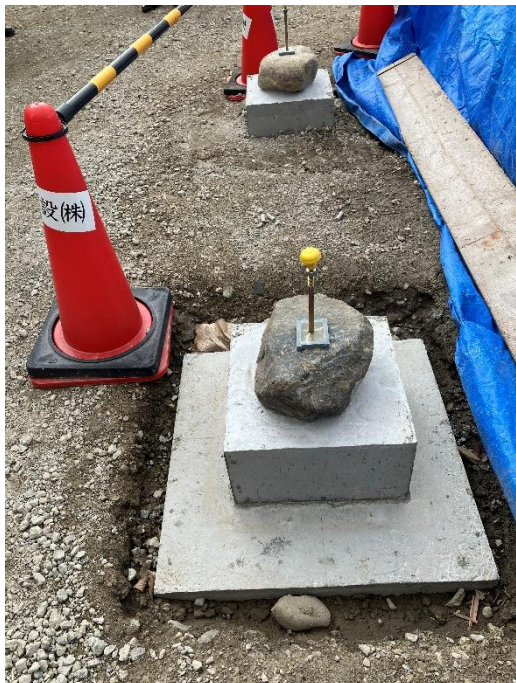
愚陀佛庵東側基礎と自然石の礎石
