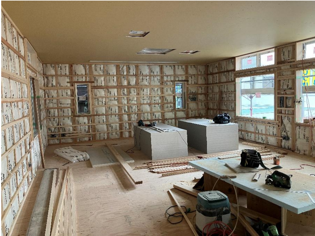
管理棟 2階多目的スペースの状況
