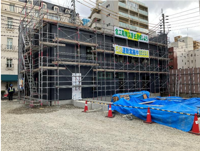
施行中の管理棟と手前は愚陀佛庵の木材準備
