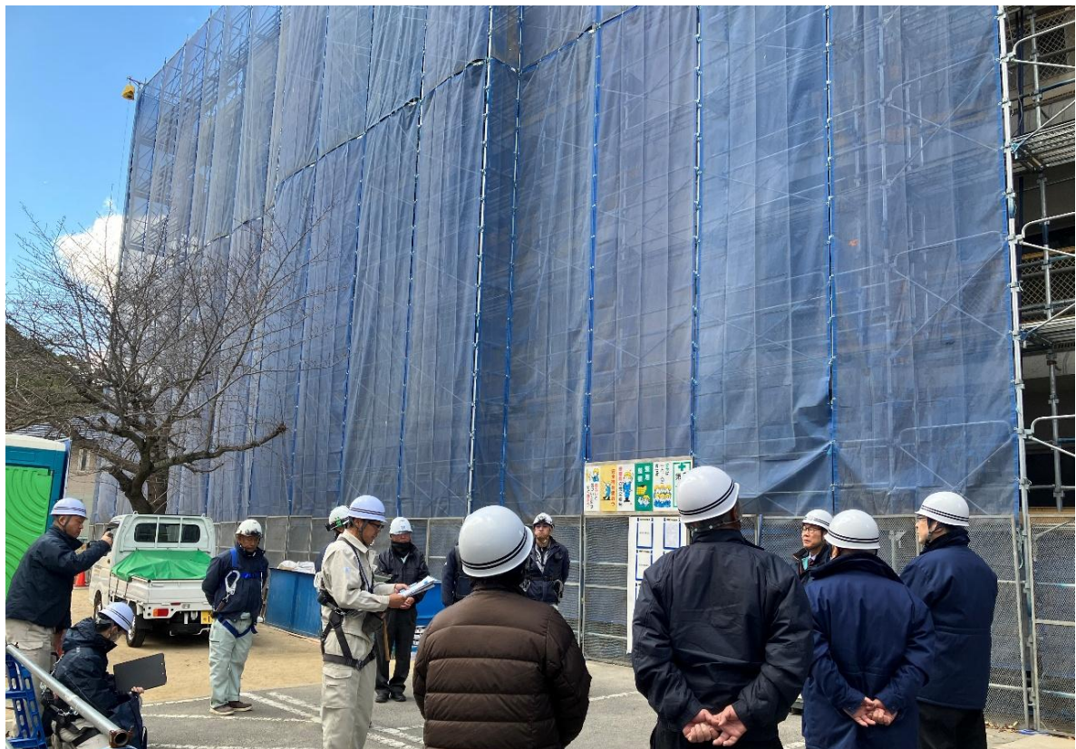
南江戸団地2号棟現場
