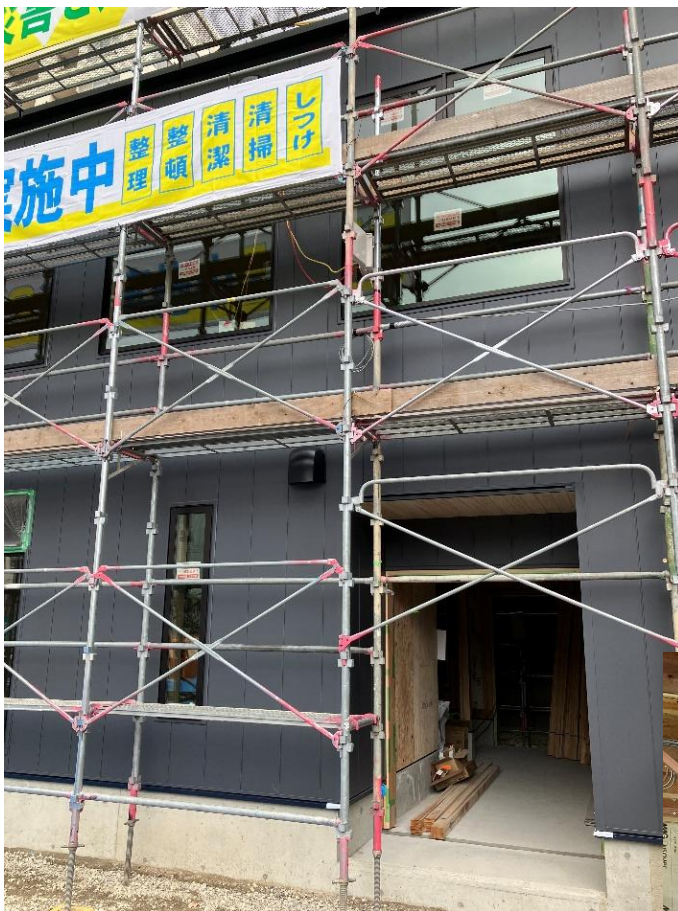
管理棟入口から中庭への出口と外壁仕上げ
