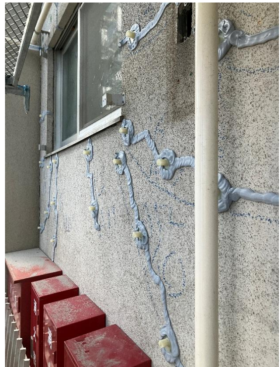
2号棟 外壁 仮止めシール材塗布と注入器台座取付
