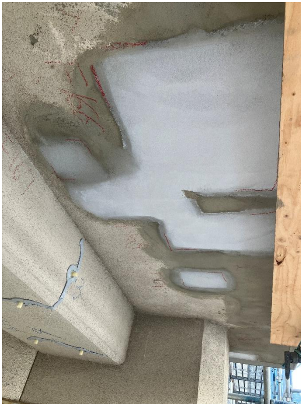
2号棟 軒下爆裂補修施工部
