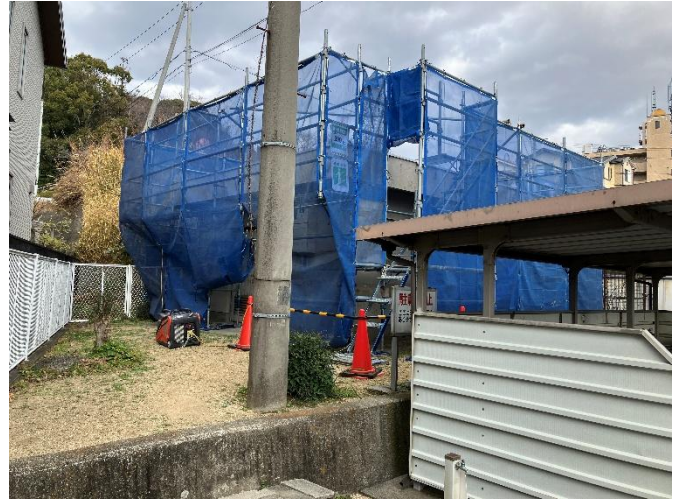
ポンプ室外壁ケレン作業中
