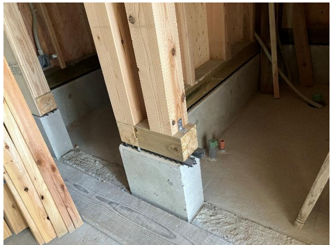
管理棟 1階土台
