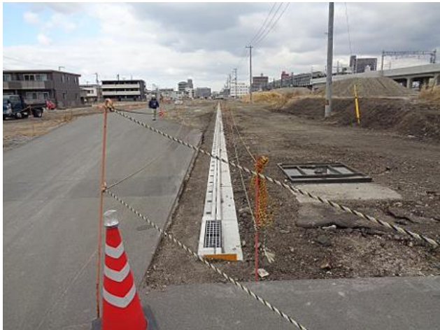
排水溝施工状況
