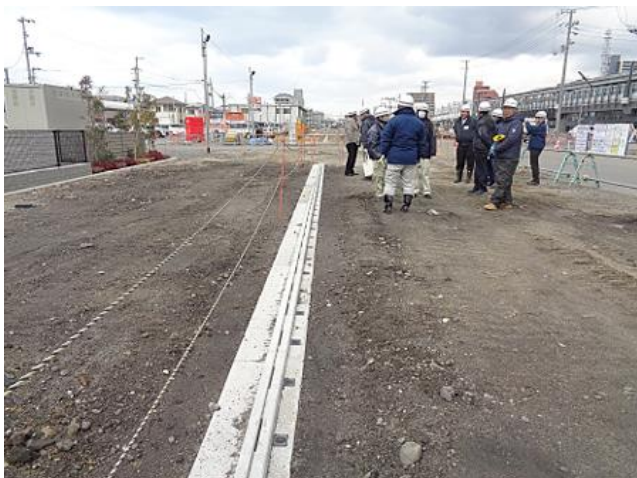
現地監査状況
