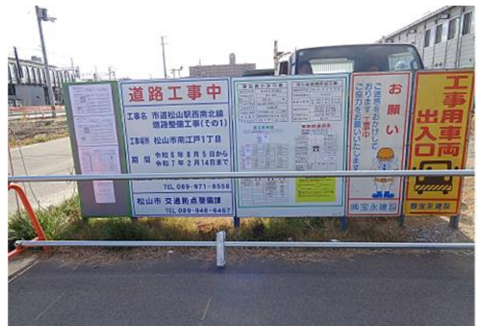
法定掲示物設置看板設置状況
