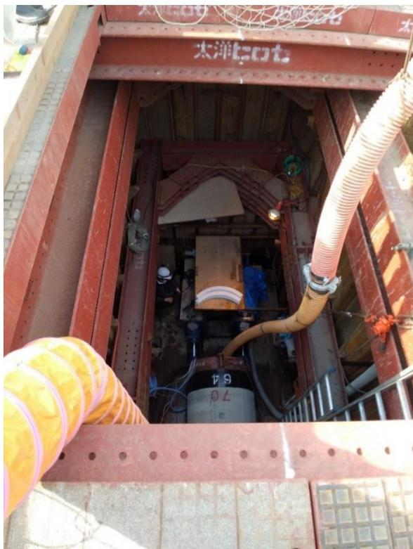
送水管布設及び推進工事 推進工ヒューム管推進状況
