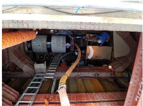
送水管布設及び推進工事 推進工ヒューム管設置状況
