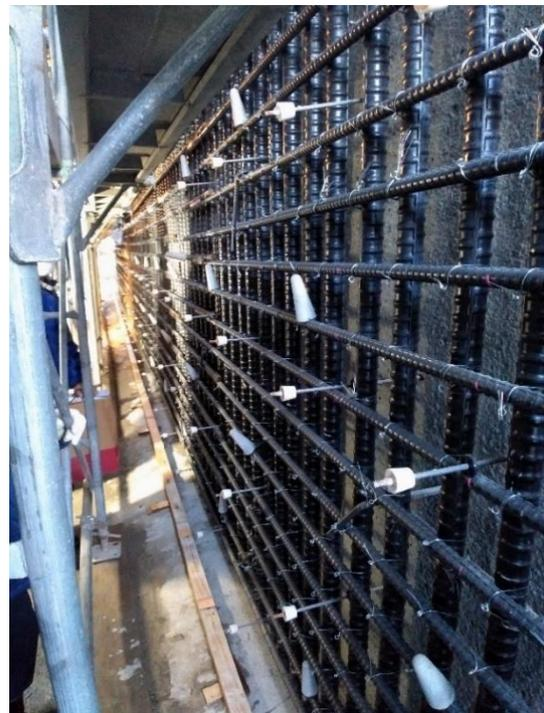
末広橋 橋脚補強工 鉄筋組立状況
