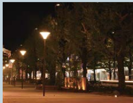
照明灯・フットライトの設置
