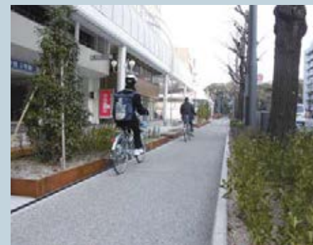
自転車道は洗出しコンクリート
