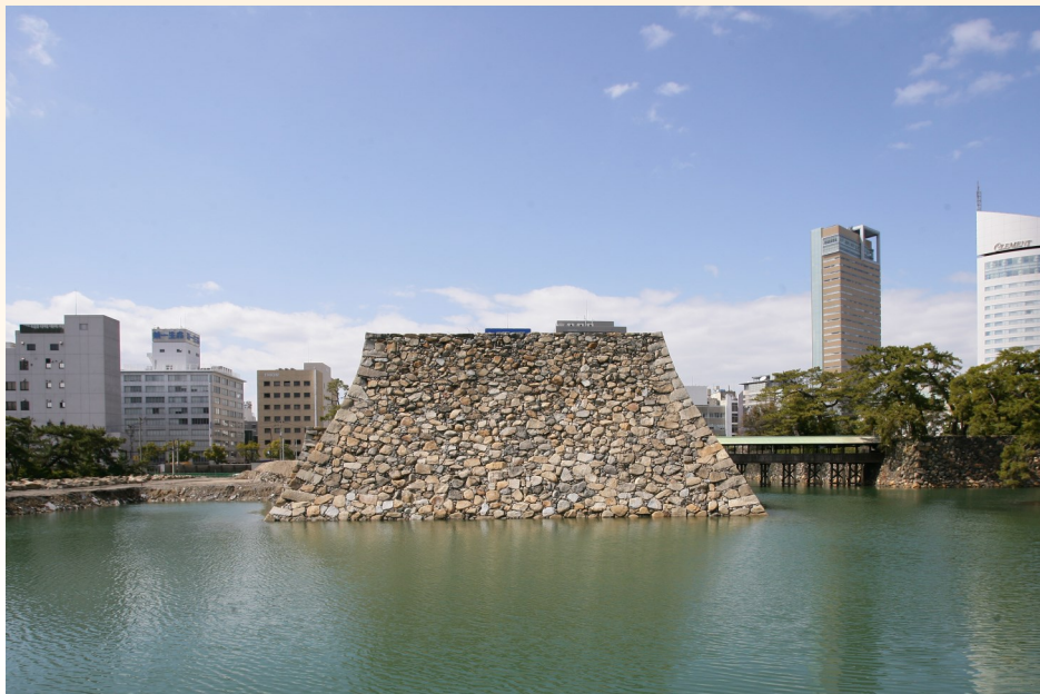
石垣解体修理を終えた高松城天守台
