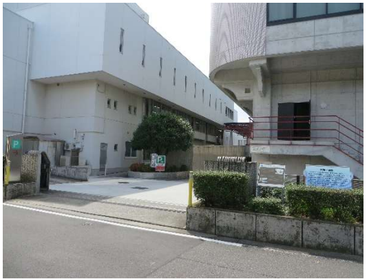
地下駐車場 出入口
