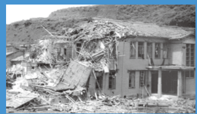
艦砲射撃による砲弾が直撃し破壊された病院(茨城県日立市)
