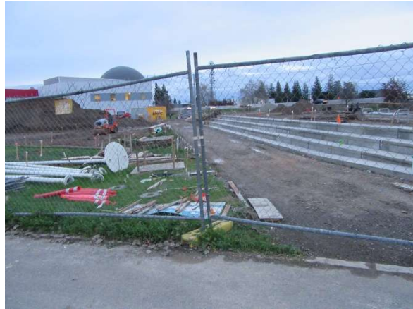
(工事中の Hanami Line)
