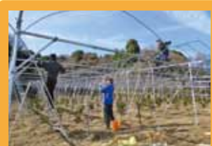
研修生とビニールハウスの組み立て作業をする様子
