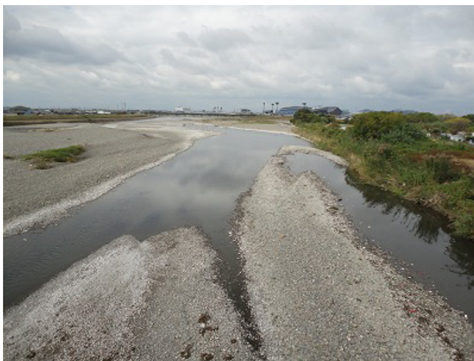
写真 重信川本川(中川原橋より下流を望む)
