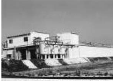
▲排水処理施設
