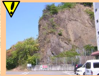
姫塚付近 調査目的の人が時々いるが、過去に落石事故もあり、現在も危険。
