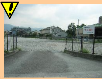
南門市営団地跡 広い空き地が、出入りできる状態のままで放置されている。周辺の家庭では敷地内に入らないように指導している。
