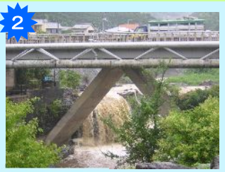
2 岩堰橋付近 急な岩場で転落の恐れや水の事故の危険がある。石手川の急な増水にも注意が必要。
