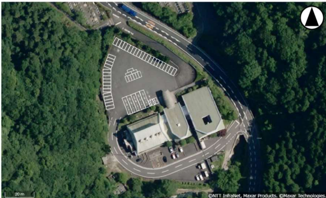
図 6-3 松山市斎場の駐車場(NTT インフラネットの地図を加工)
