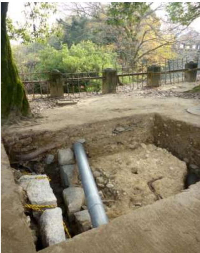
写真13 トレンチ4bと本丸石垣(北西から)
