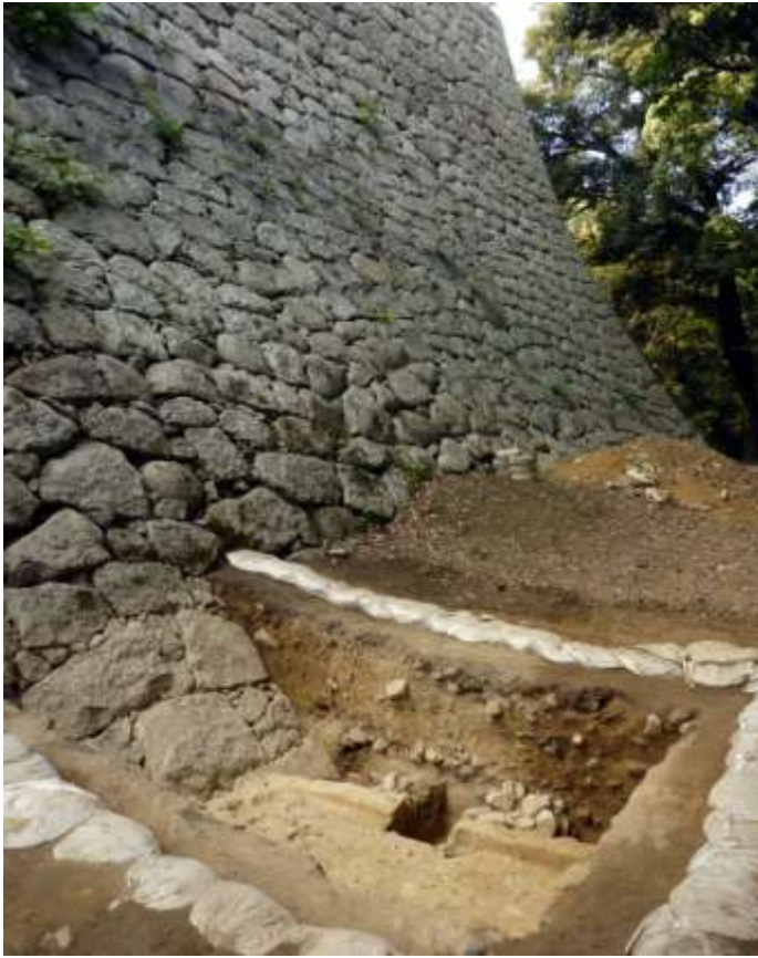
写真1 トレンチ1と本丸石垣(南東から)
