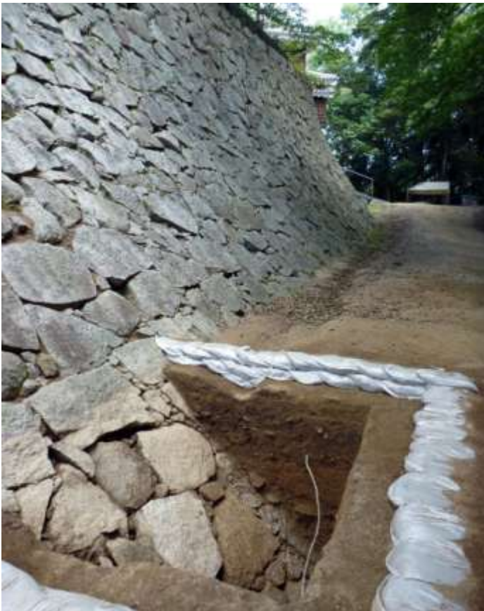
写真4 トレンチ2aと本丸石垣(南から)
