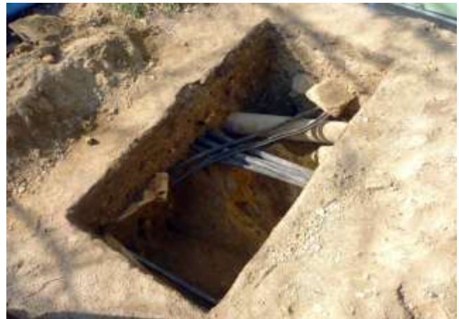
写真31 トレンチ10b(南東から)
