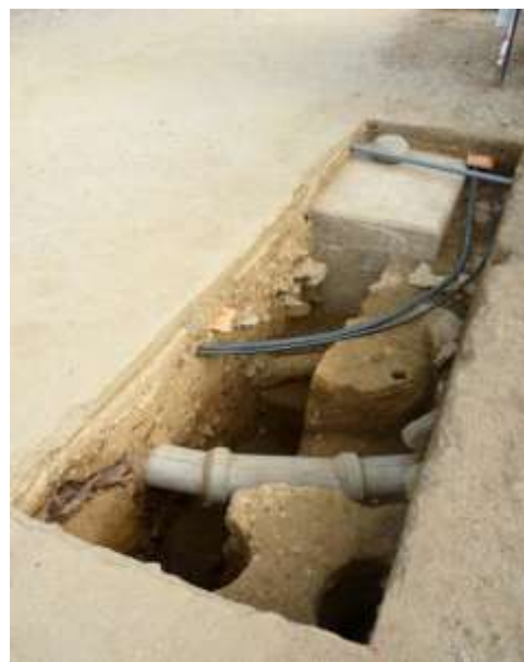
写真23 トレンチ7c(南西から)
