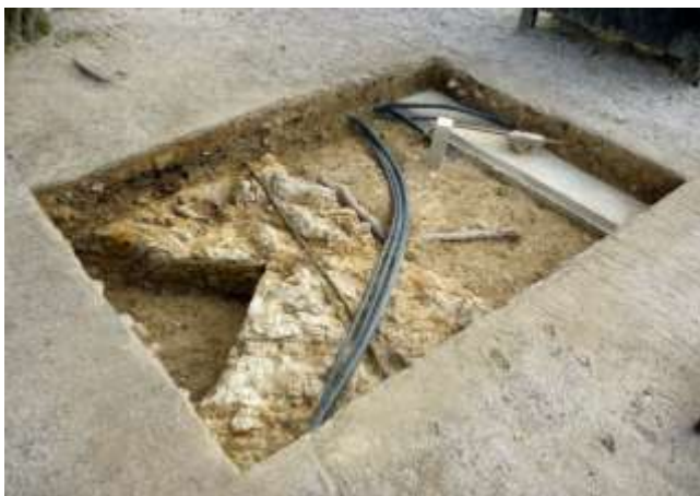
写真21 トレンチ7a(北西から)
