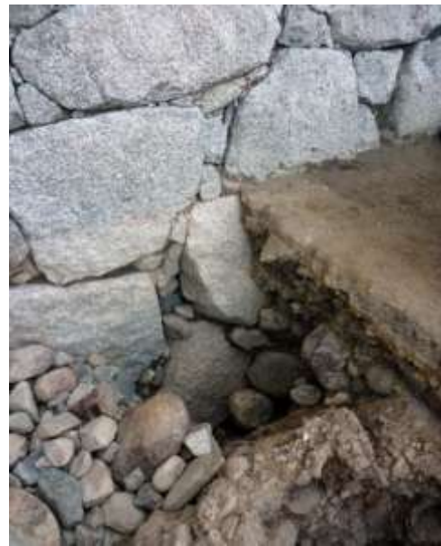
写真27 トレンチ8 石垣根石(北から)
