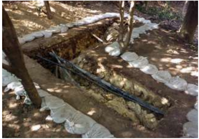
写真29 トレンチ9b(南東から)
