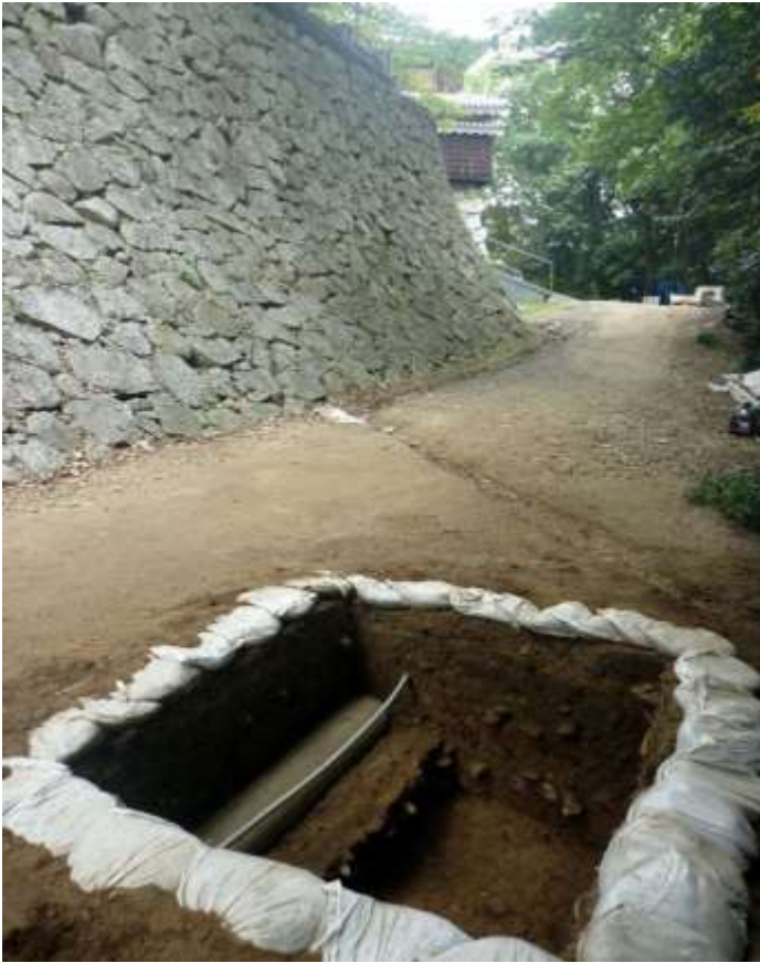
写真6 トレンチ2bと本丸石垣(南から)
