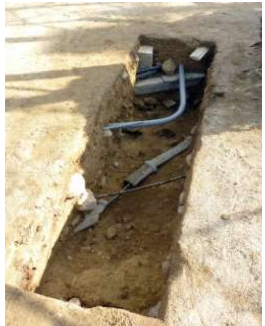
写真33 トレンチ10c(北東から)
