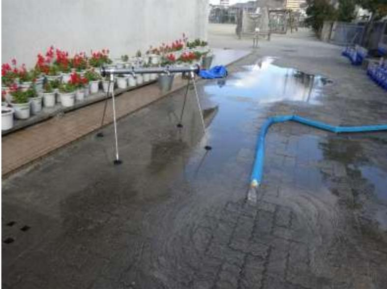
※何らかの**はずみ**でホースが抜けてしまっても焦らず、**ゆっくり**応急給水栓を閉めてください。
