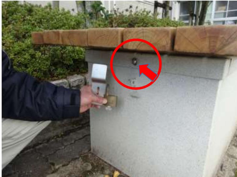
鍵を外し、プレートをのけるとネジで固定されています。
