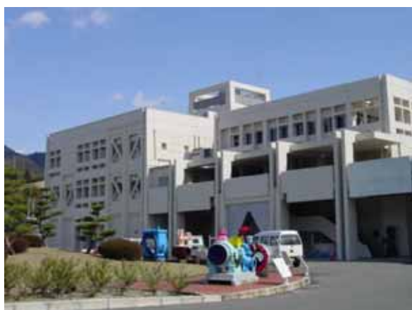
市之井手浄水場 管理本館
