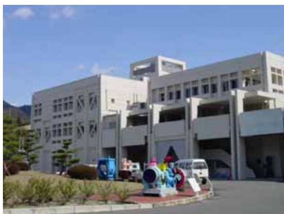
市之井手浄水場 管理本館
