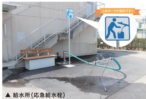
▲ 給水所(応急給水栓)
