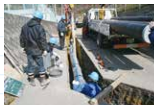
耐震管への取替工事
