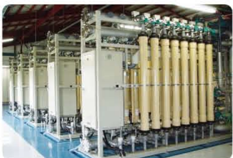
かきつばた浄水場の膜ろ過設備。筒型の設備の中は、目に見えない超微細な穴のあいた膜になっています。
