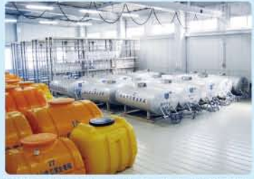
資材の備蓄倉庫。給水タンクや水道資材を保管し緊急時に備えています。
