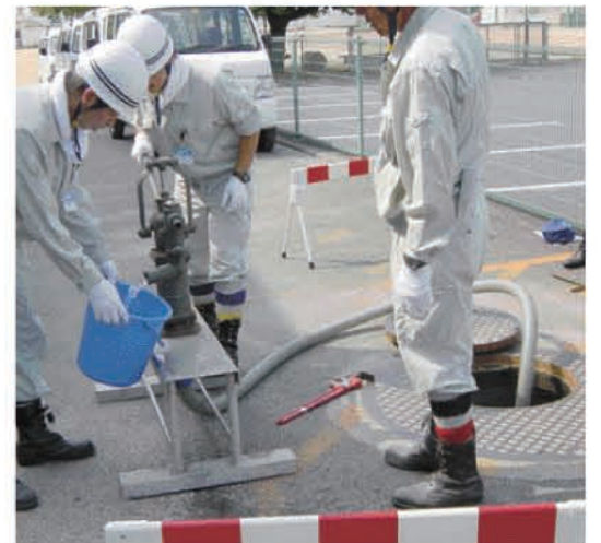
緊急用貯水槽操作訓練の写真
