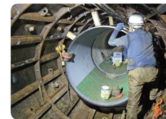
▲シールド工事の様子
