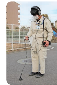
▲漏水調査の様子
