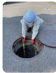
▲マンホール点検の様子
