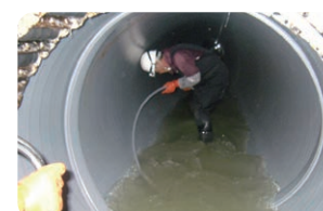
▲耐震化工事の様子
