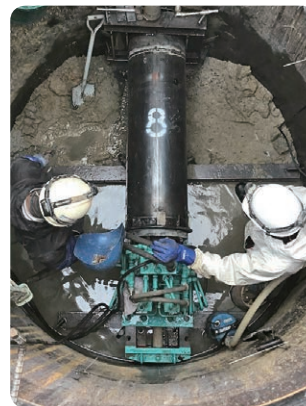
▲汚水管の敷設工事の様子
