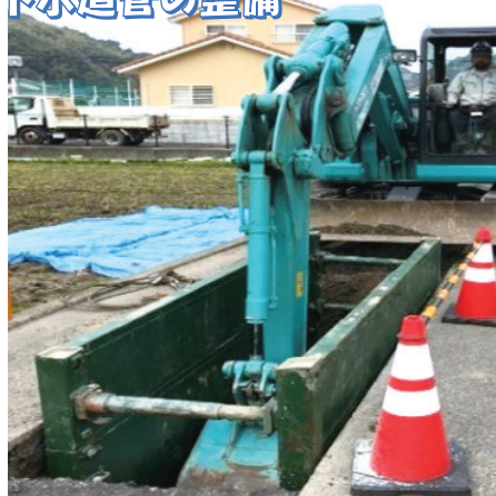
下水道管の整備
