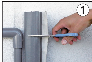
① 管の長さに合わせて保温材をカットする。
