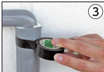
③ 保温材が外れないように水に強いテープなどでしっかりと巻く。
