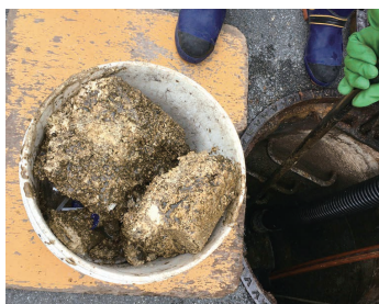
下水道管内で固まった油
