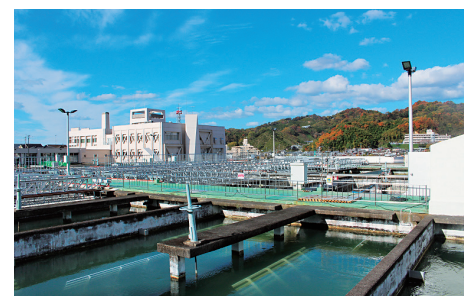
▲市之井手浄水場
