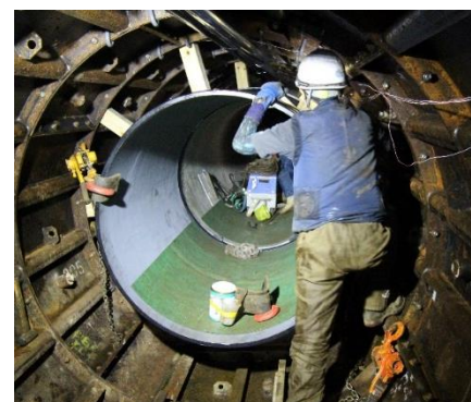
▲市之井手系導水管シールド工事
