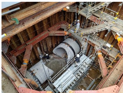
▲立坑内の様子
