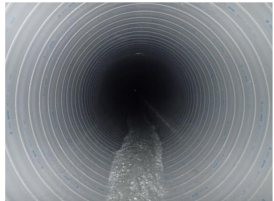
▲プラスチック材等で既存管渠の内面を被覆
