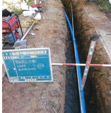
▲東中島地区の老朽化した配水管の更新
