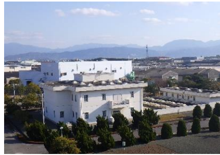
▲西部浄化センター 揚水施設
