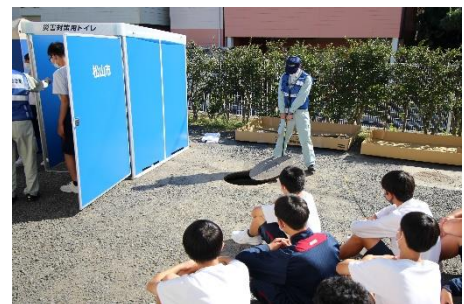
▲災害用マンホールトイレの組立訓練の様子
