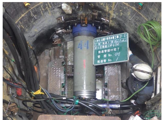
▲下水道の推進工事の様子
