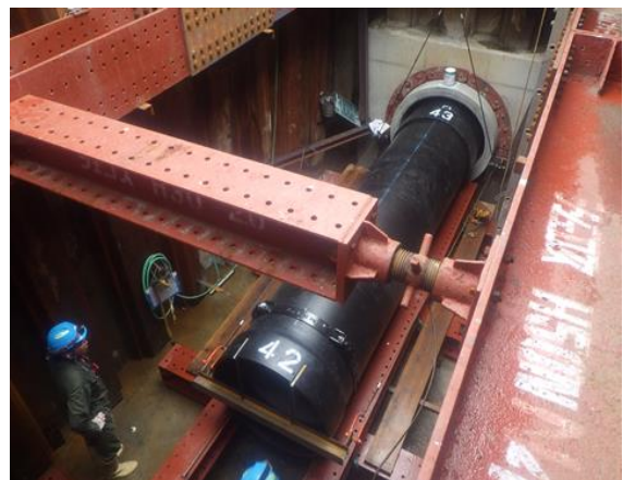
▲工業用水道管の耐震化工事
