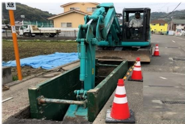
▲下水道の開削工事の様子
