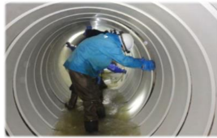
▲緊急輸送路下の管渠耐震化工事(管更生工法)
