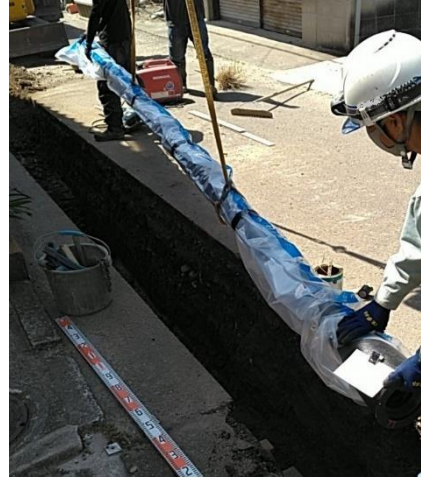
▲耐震管への更新工事
