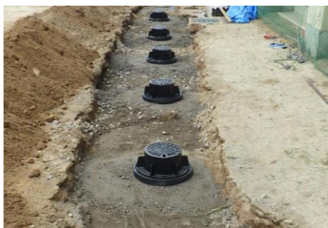
▲マンホールトイレ設置工事の様子
