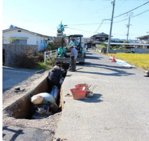
（老朽化した配水支管の更新） （水質管理棟での水質検査の実施）
