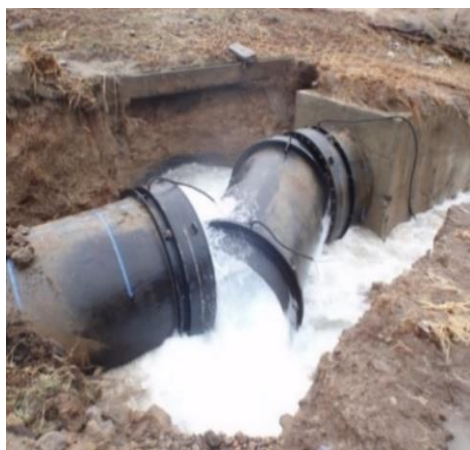
被害を受けた 水道管
