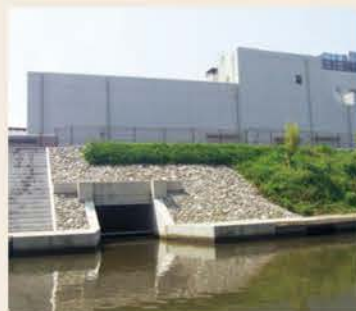
和泉雨水排水ポンプ場
