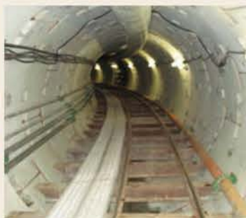
朝生田雨水管(管径2.4m)
