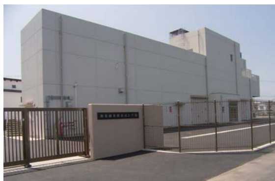
和泉雨水排水ポンプ場（和泉地区）
