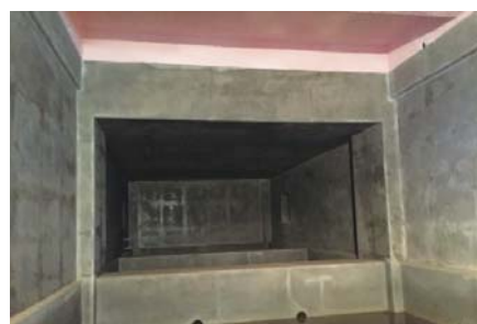
貯留槽内部写真
