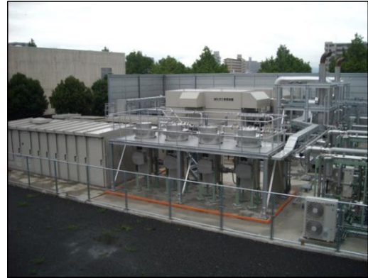
図表 14 消化ガス発電設備（中央浄化センター）
