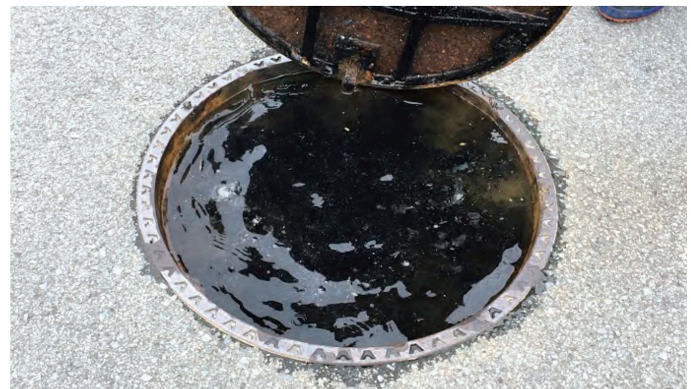
油や異物が詰まると逆流してマンホールからあふれることも
