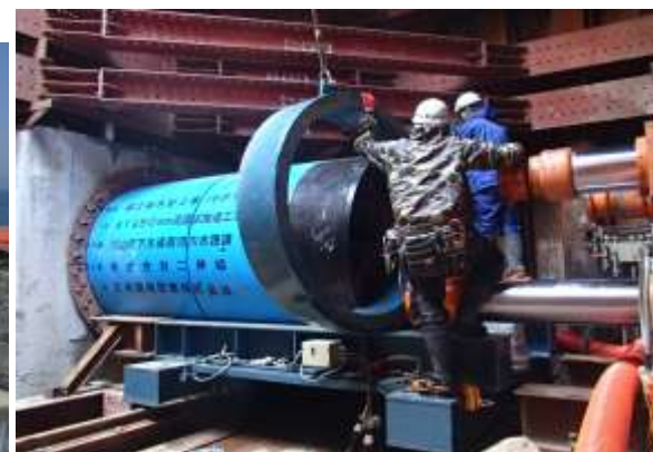
堀江雨水管（整備中）
