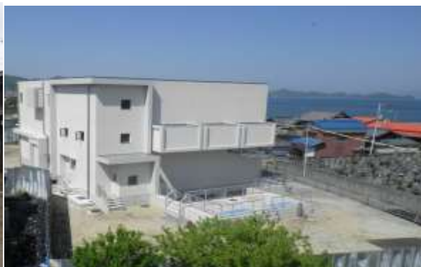
堀江第1雨水排水ポンプ場（整備中）
