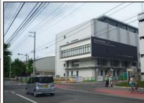
教育研修センター （地下部に雨水貯留槽）
