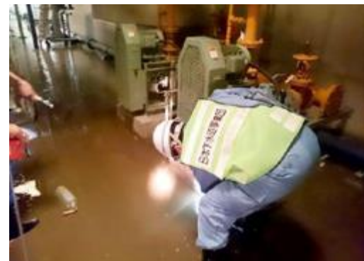
益城町浄化センター 【漏水による機器異常の点検】 (出典:国土交通省)
