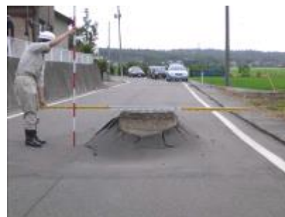
【マンホール浮上】 出典: 柏崎市
