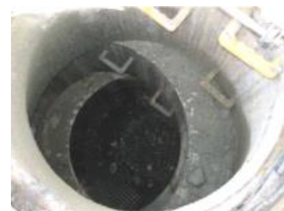
【マンホール躯体の目地ずれ】 出典: 仙台市
