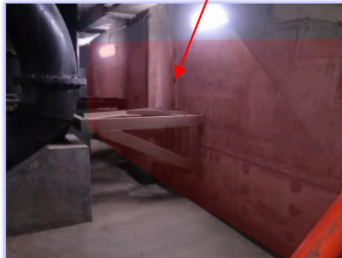
【中央処理場(沈砂池ポンプ棟)耐震補強工事】
