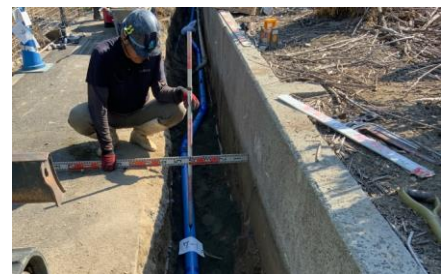
▲東中島地区配水管整備工事
