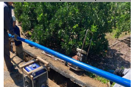
▲東中島地区配水管整備工事
