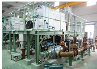
▲ 汚泥濃縮機械設備改築工事
