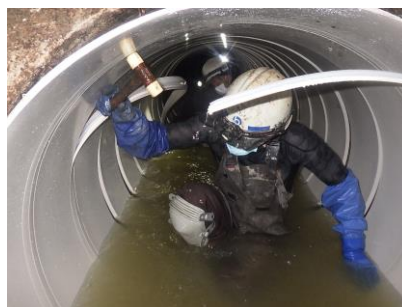
▲ 下水道管渠耐震化工事
