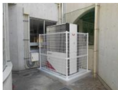
エアコン室外機
