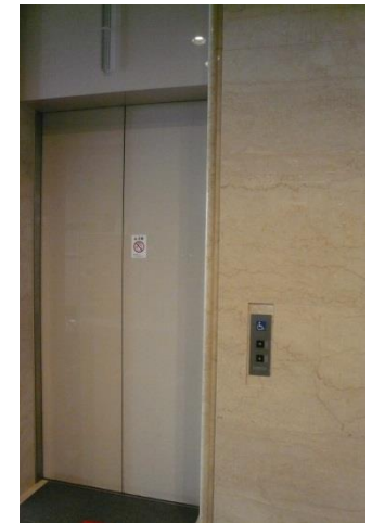
エレベーター(ボタン)
