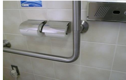
手すり (トイレや廊下)
